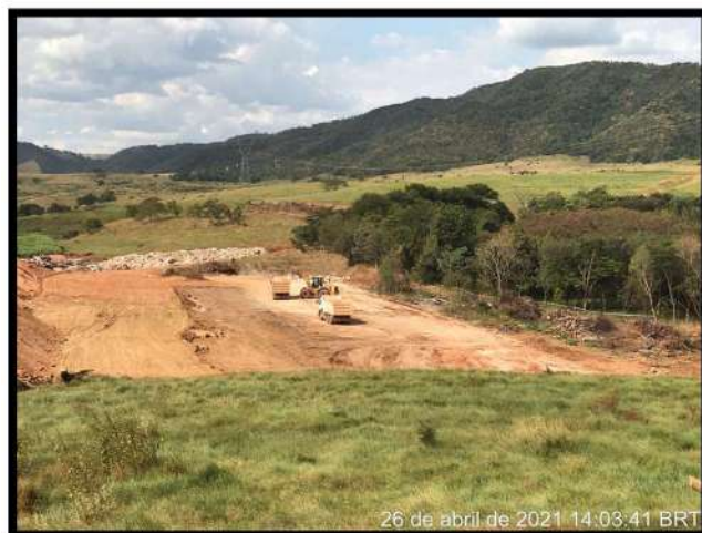
Foto 4 – Panorama com finalização do desmonte da granja. Estruturas 116 a 120. Data: 26/04/2021.
