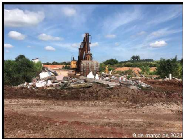
Foto 2 – Atividade de demolição da granja. Estruturas 116 a 120. Data: 09/03/2021
