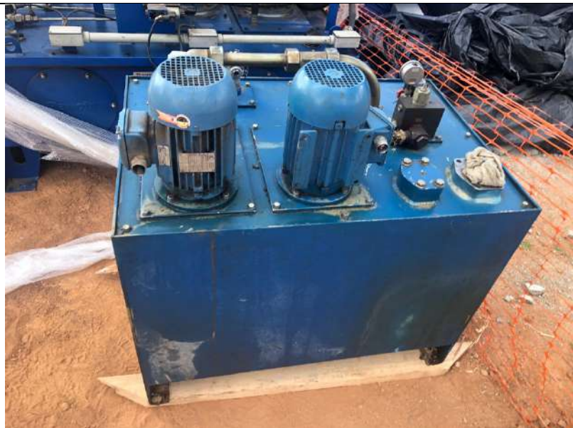
Foto 2: Desmonte dos equipamentos da PCH Feixos. Data 23/04/2021
