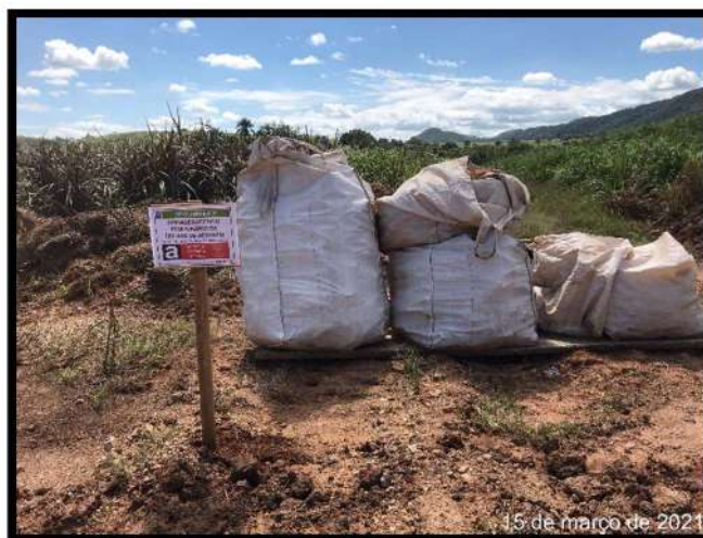
Foto 1 – Armazenamento provisório de material (Data: 15/03/2021).
