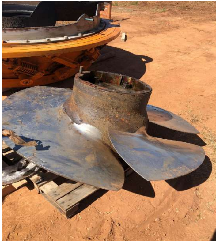
Foto 3: Desmonte dos equipamentos da PCH Feixos. Data 23/04/2021
