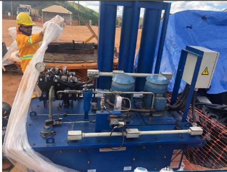
Foto 1: Desmonte dos equipamentos da PCH Feixos. Data 23/04/2021
