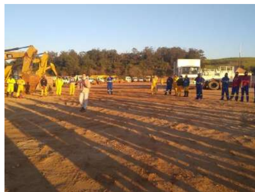
Foto 2 – DDS sobre Trânsito no entorno da obra – Data: 10/05/2021
