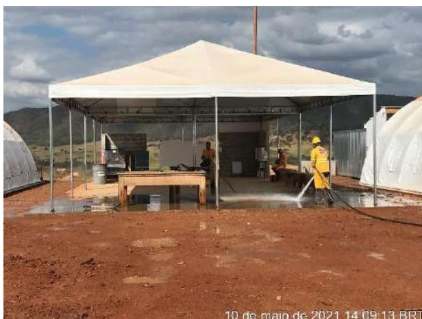
Foto 7 – Limpeza da área de vivência do canteiro industrial (Data:10/05/2021)
