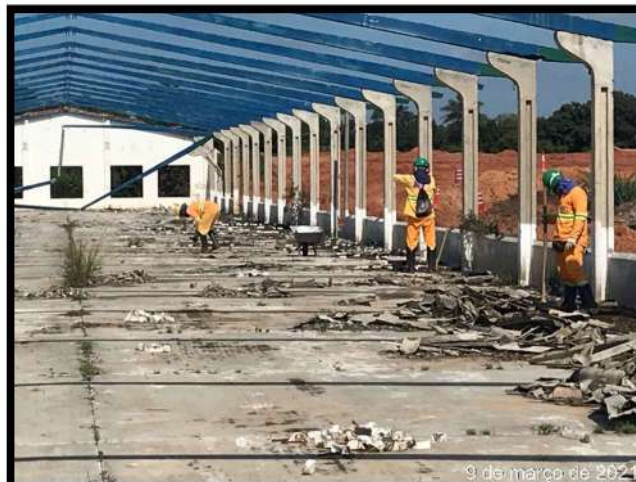
Foto 3 – Atividade de segregação de material. Estruturas 116 a 120. Data: 09/03/2021
